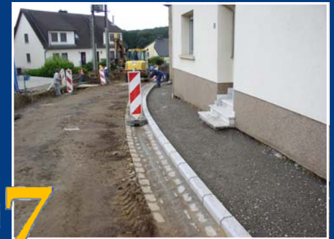
Fortsetzung der Straßenarbeiten im Merschgrund.
