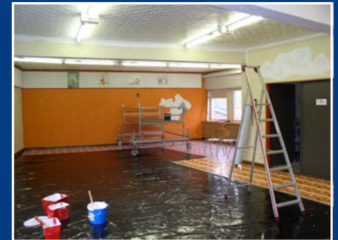
Renovierung des Saales im früheren Gebäude der Feuerwehr Hobscheid für den Jugendverein JOC.
