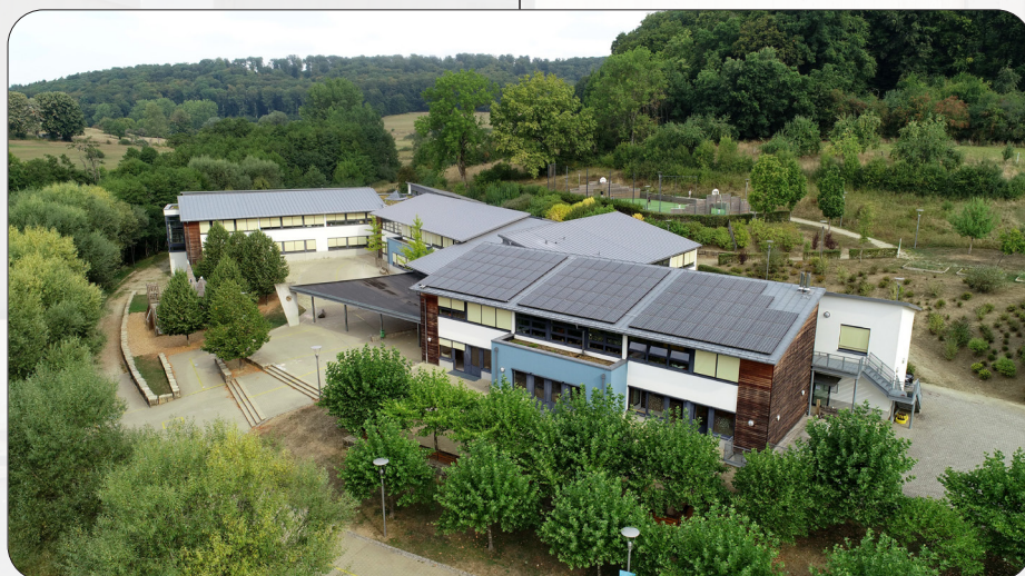
Le bâtiment de l'école «Vir Wëller» à Eischen.
